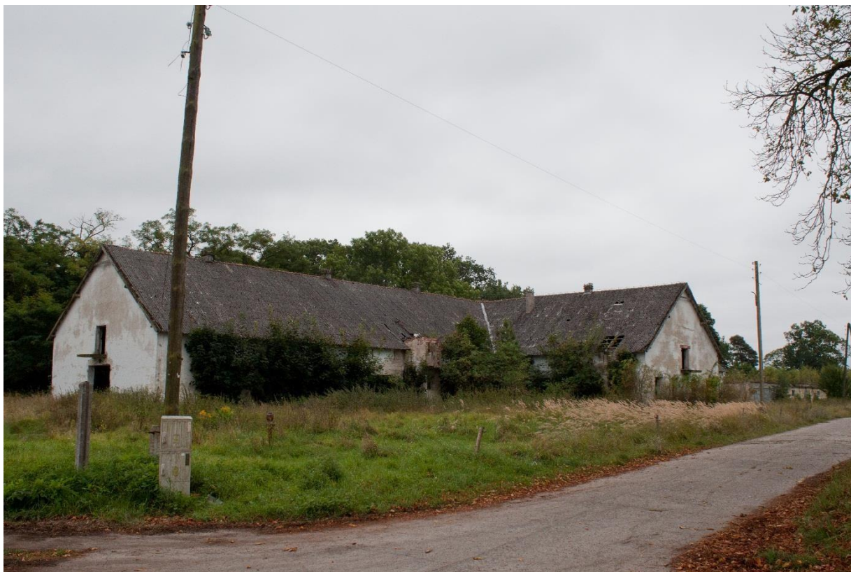
Zdjęcie 10. Budynek po byłym PGR na terenie miejscowości Rzędziny
