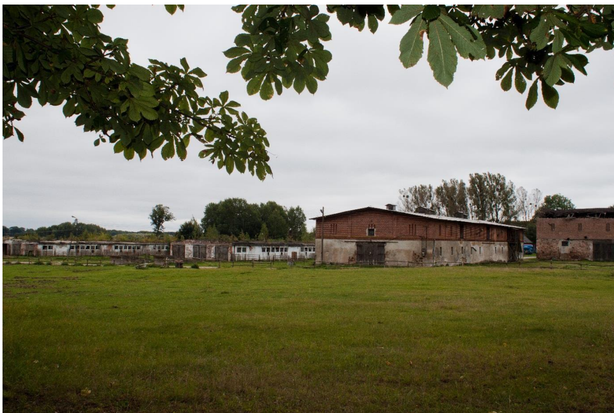
Zdjęcie 6. Zabudowa po byłych PGR-ach na terenie miejscowości Stolec
