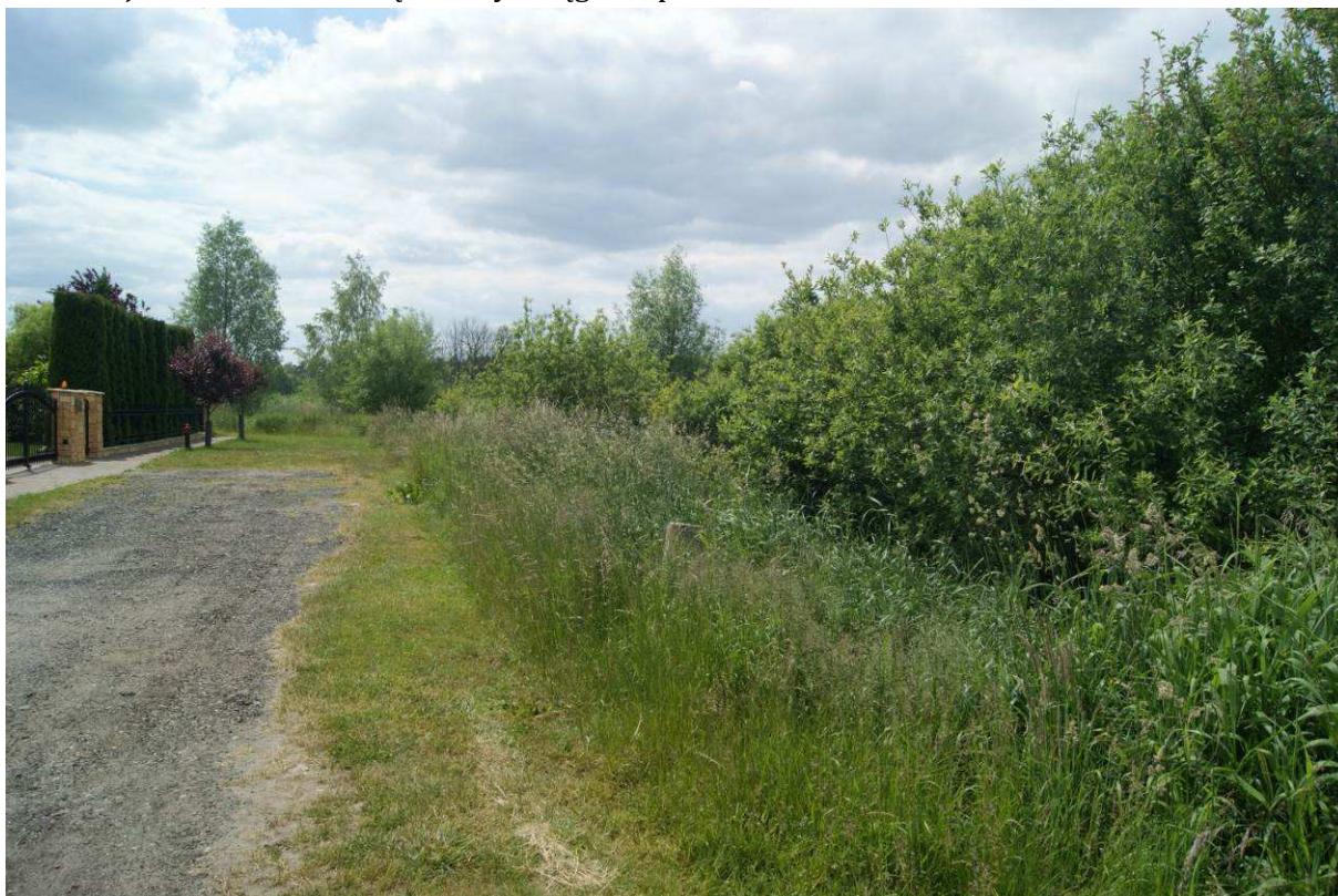
Fot. 1. Istniejąca droga utwardzono przeznaczona do modernizacji
