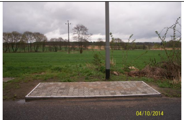
Fot. 2 Istniejący „peron” po stronie wschodniej
