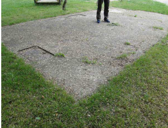
Fot.1 Widok płyty przykrycia
