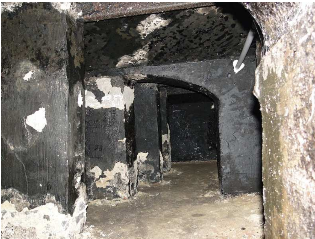
Zdjęcie nr 6, 7 i 8. Widok zawilgoceń na ścianach
