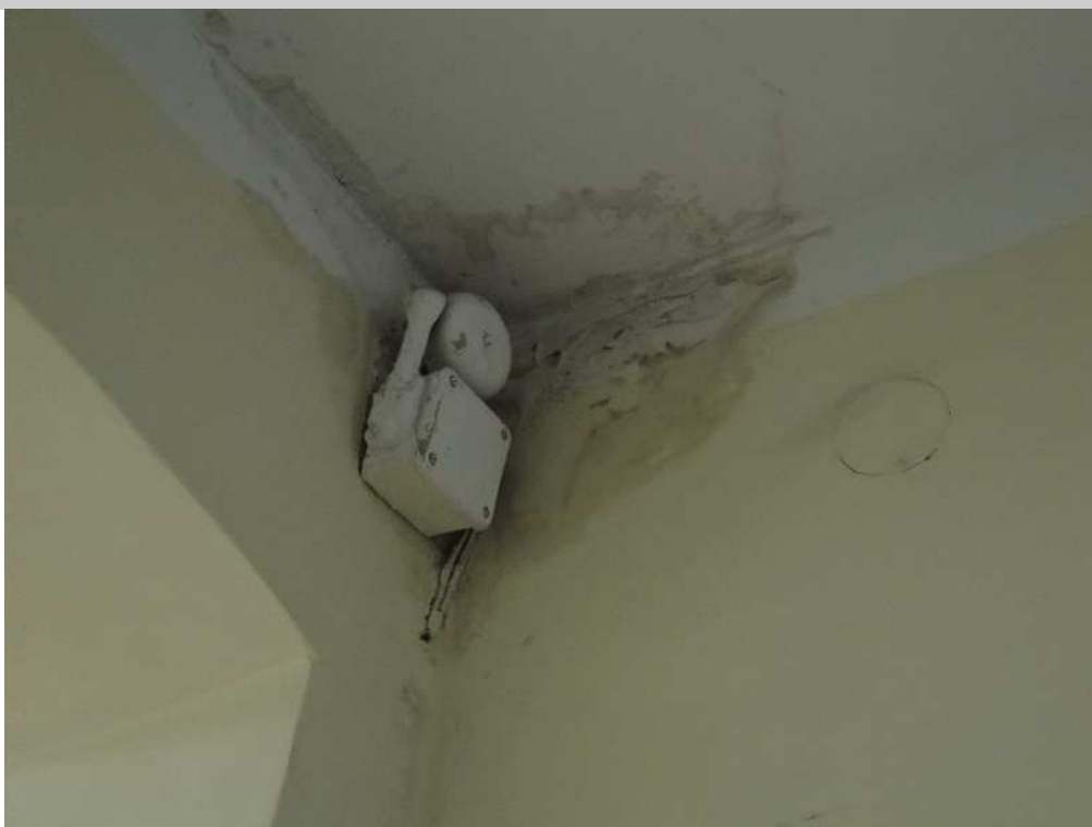
Zdjęcie nr 6, 7 i 8. Widok zawilgoceń na ścianach
