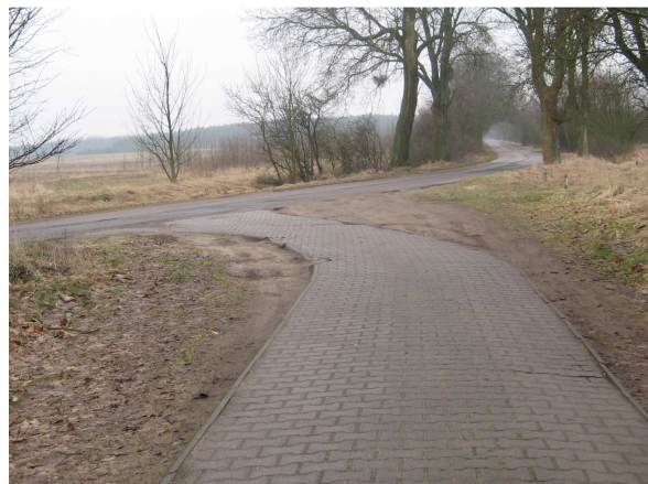
Fot. 2 Skrzyżowanie z drogą powiatową 0607 Z
