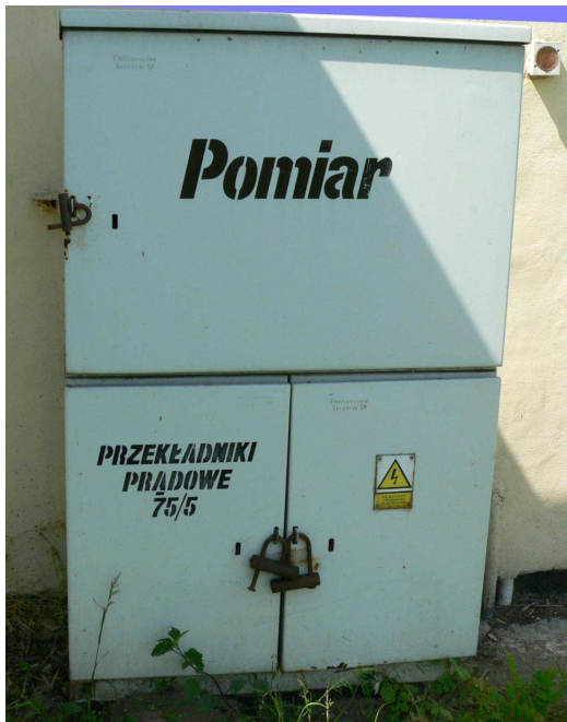
Pomiar na budynku hydroforni
