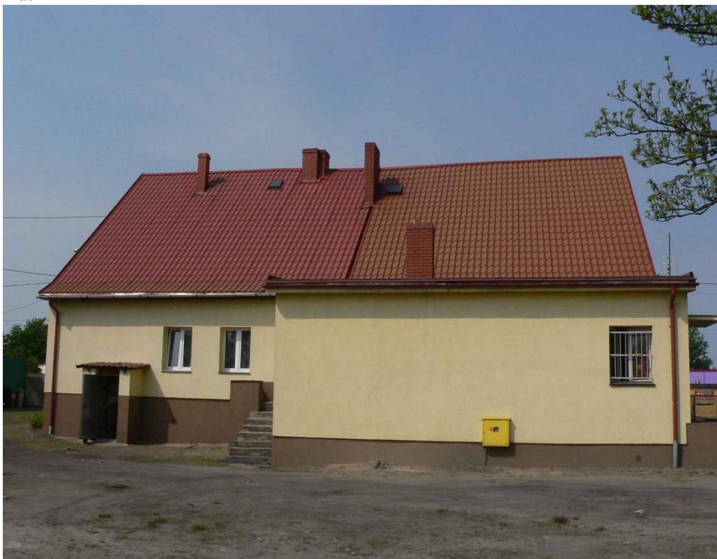
Widok elewacji wschodniej (od strony podwórza)
